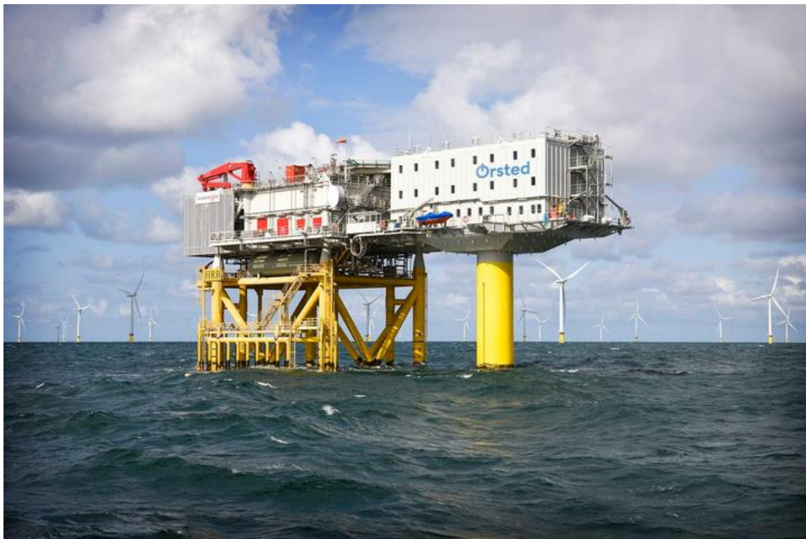
Rysunek 8.2 Przykładowa stacja elektroenergetyczna (po lewej) i platforma mieszkalna (po prawej) na morskiej farmie wiatrowej Horns Rev 2. Platforma mieszkalna jest posadowiona na fundamencie jednopalowym, natomiast stacja posiada fundament kratownicowy.
