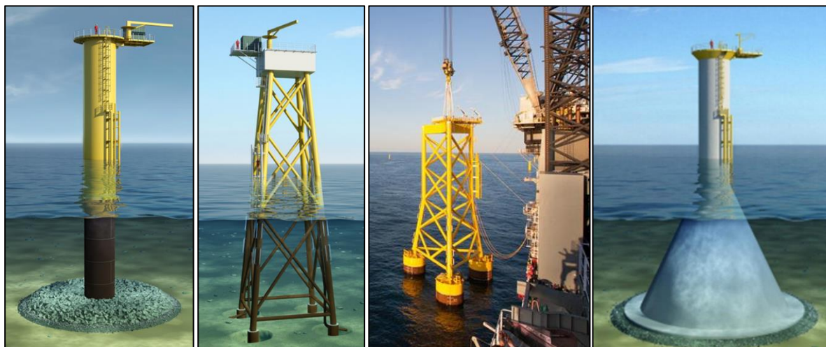
Rysunek 8.3 Od lewej do prawej: (1) Fundament jednopalowy z zainstalowanym elementem przejściowym i ochroną przed wymywaniem na dnie morskim. (2) Fundament kratownicowy z elementem przejściowym. (3) Morski keson ssący. (4) Fundament grawitacyjny z elementem przejściowym i ochroną przed wymywaniem. (Ilustracje: Ramboll, Zdjęcia: Borkum Riffgund)
